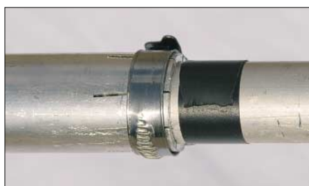
Bild 5: Die verschiebbaren Rohrübergangsstücke mit der Schlauchschelle
