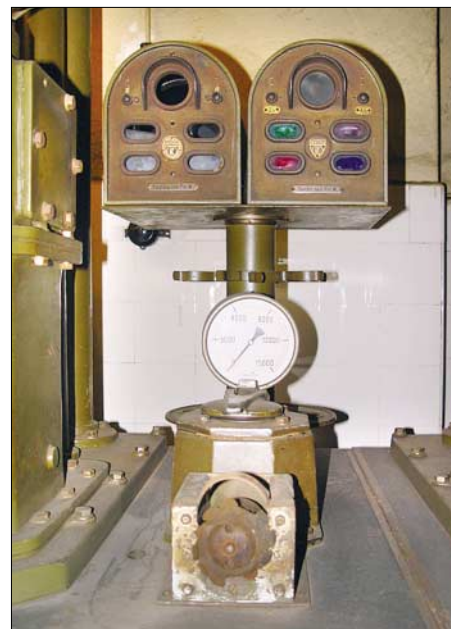
Bild 6: Rohrpost-Büchsenzählwerk und Luftstromanzeiger (Steuerungsanzeige), 1929
